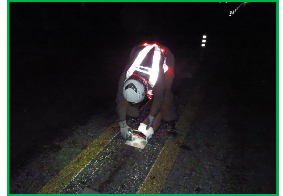
コア削孔スプレーマーキング状況
