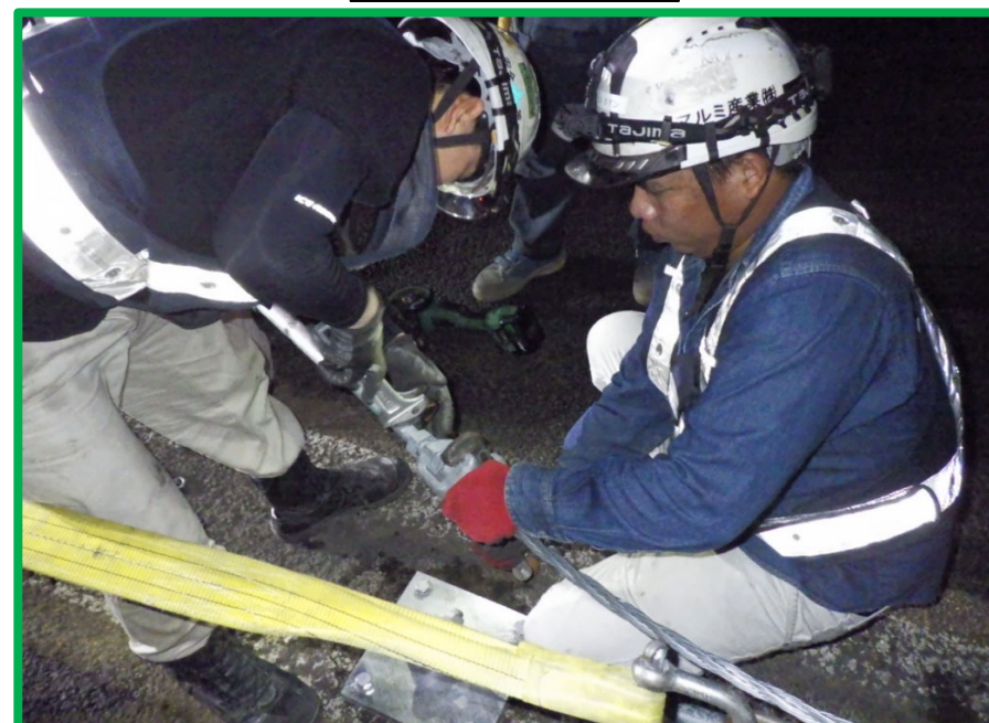
索端金具取付状況
