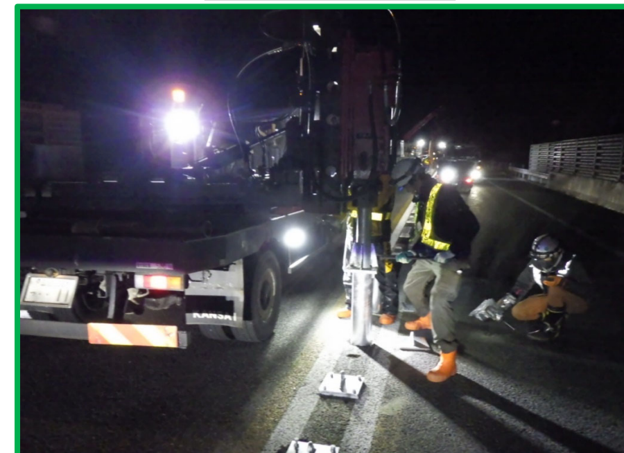
端末鋼管杭打込み状況
