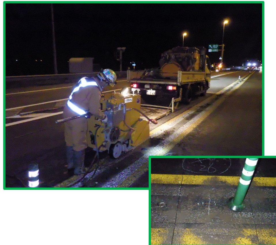
既設舗装版切断状況
