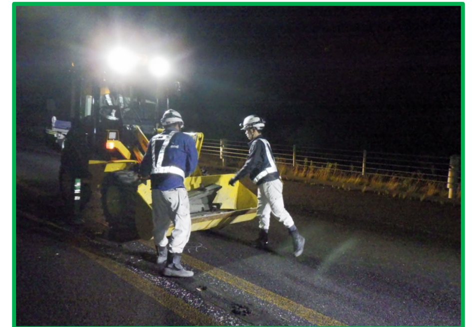
PCC縁石回収状況(人力)
