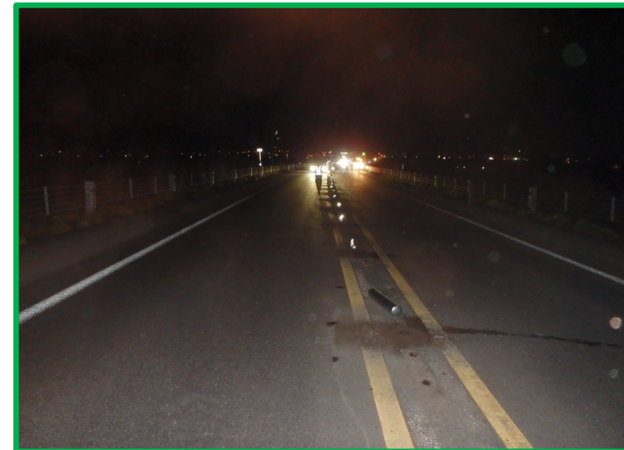
スリーブ鋼管配材完了
