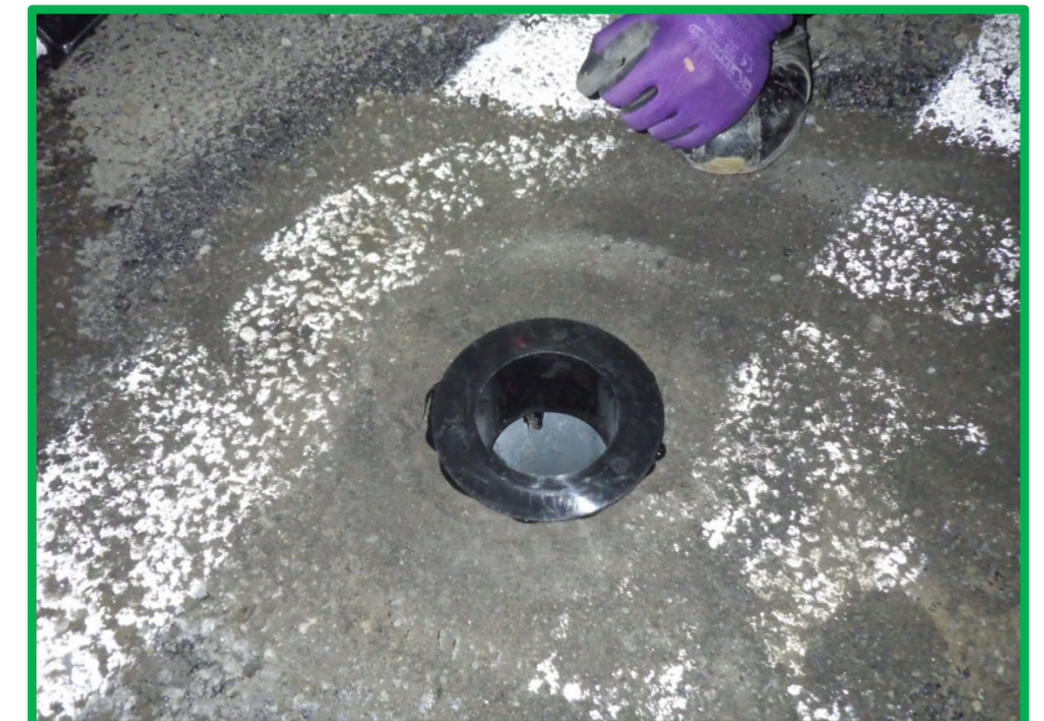
間詰・コキグ・スリーブが-設置完了
