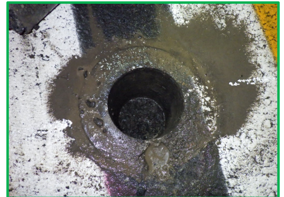
Asコア削孔完了(エンジン式)
