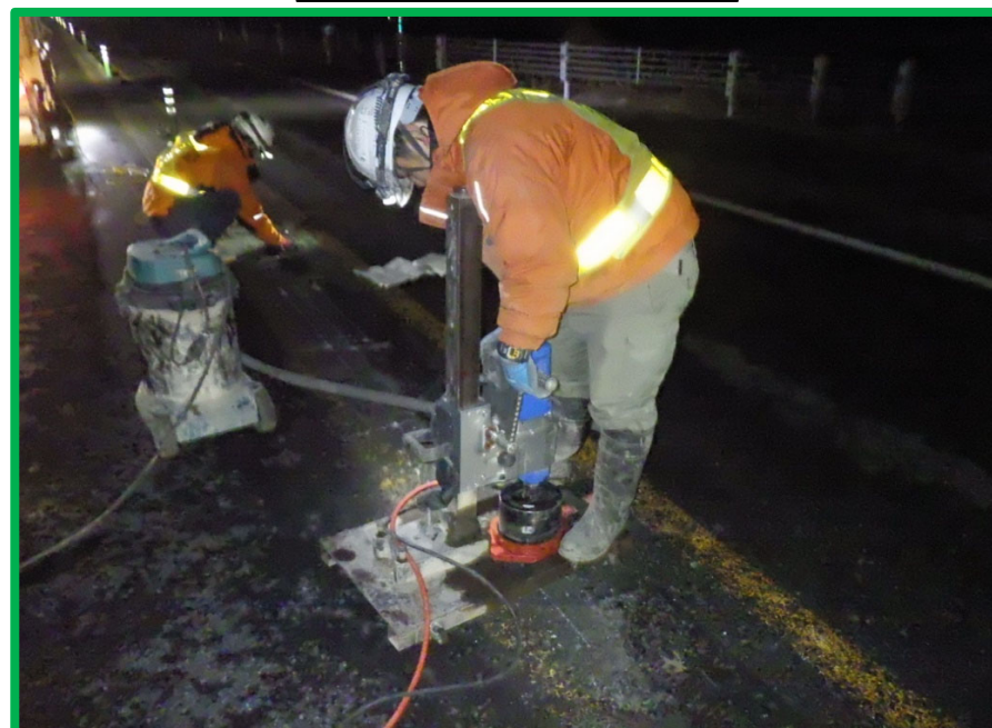
Asコア削孔状況(電動式)
