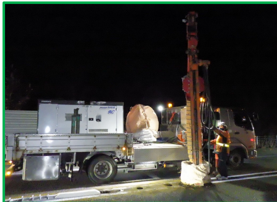
端末鋼管 岩削状況
