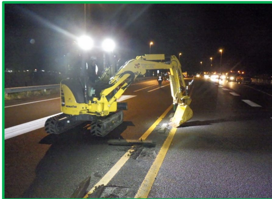
PCC縁石撤去状況(バックホウ)
