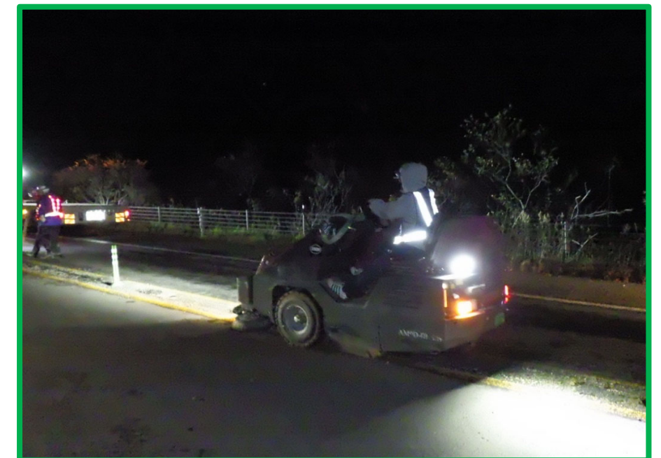
路面清掃状況
