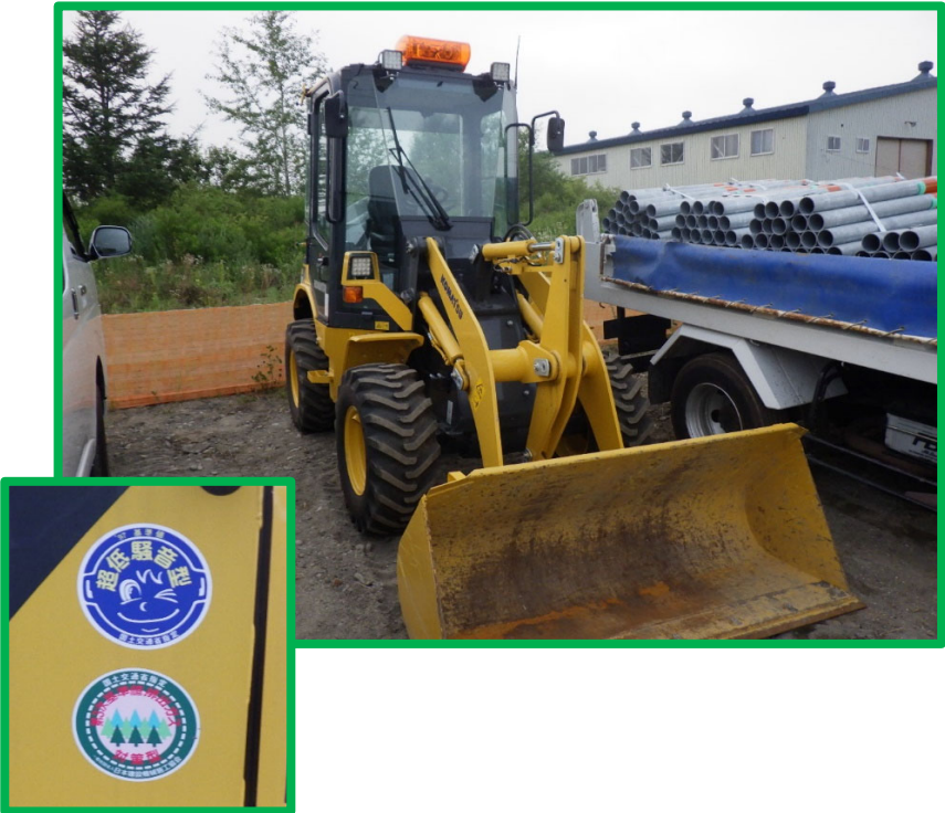
0.4m 3 級タイヤショベル【WA-30】 (撤去材積込・ワイヤー張補助用)
