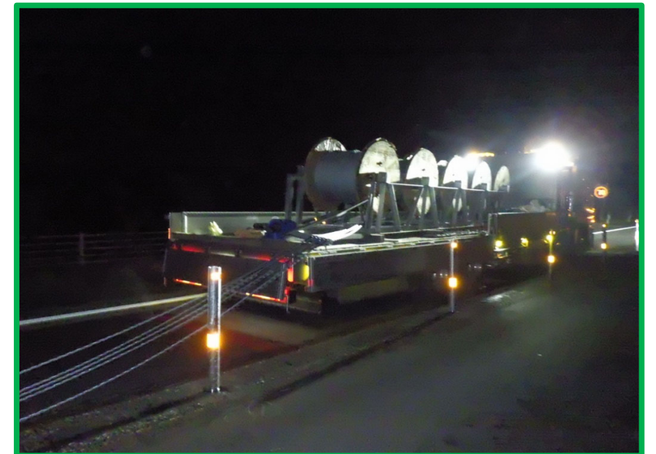
ワイヤーロープ設置状況(専用架台)
