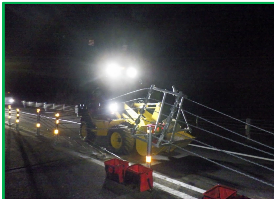
ワイヤーロープ設置状況(専用治具)
