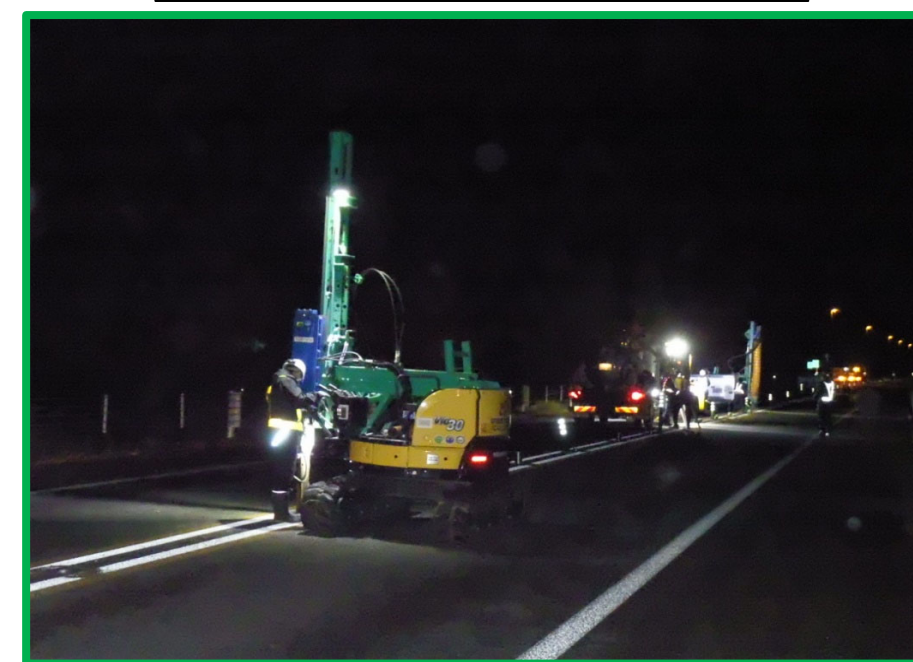
岩削→土砂回収→路面清掃→打込み 全景
