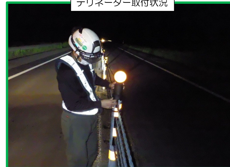
端部斜め反射材取付完了
