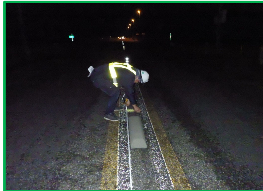
4mピッチマーキング状況
