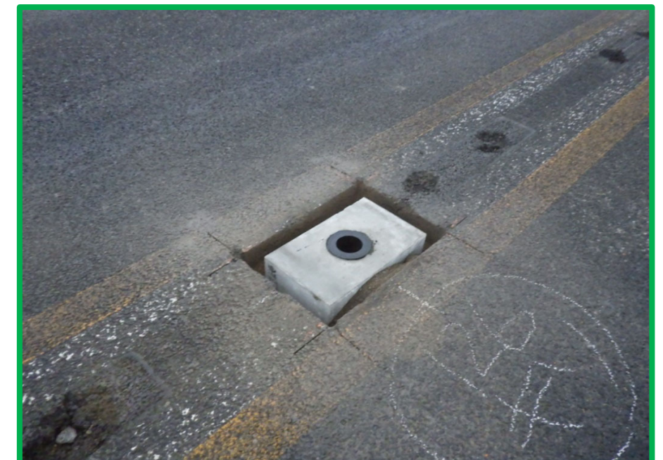
基礎ブロック設置完了
