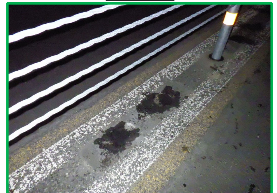
舗装復旧完了
