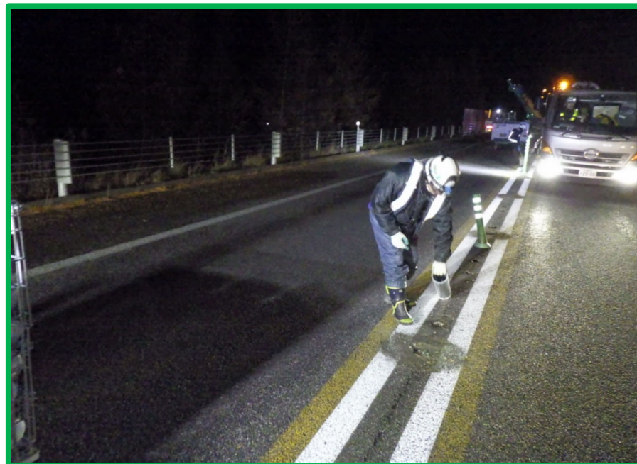
スリーブ鋼管配材状況
