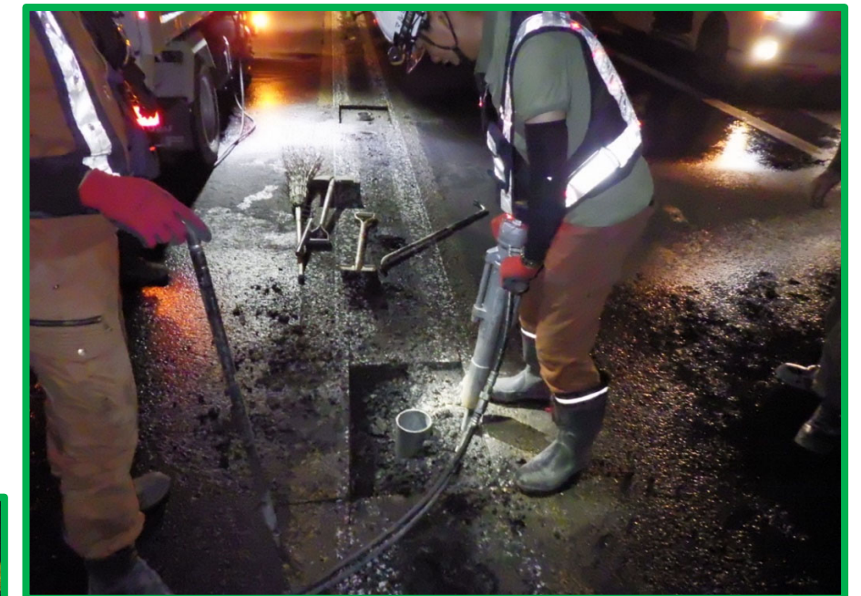
既設舗装版撤去状況(人力はつり)
