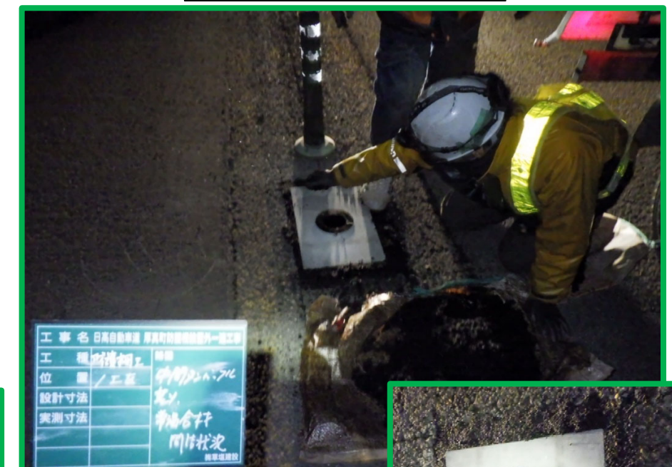
間詰復旧完了(常温合材使用)
