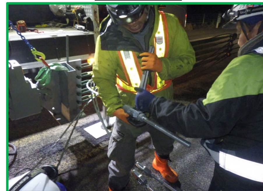
中間ターナックル設置完了
