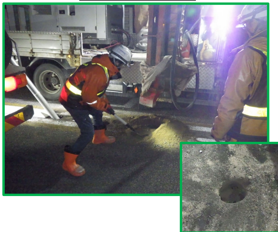
排出土砂孔内埋戻し状況
