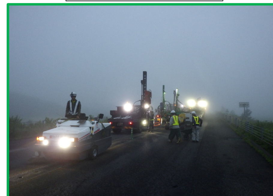
岩削→土砂回収→路面清掃 全景
