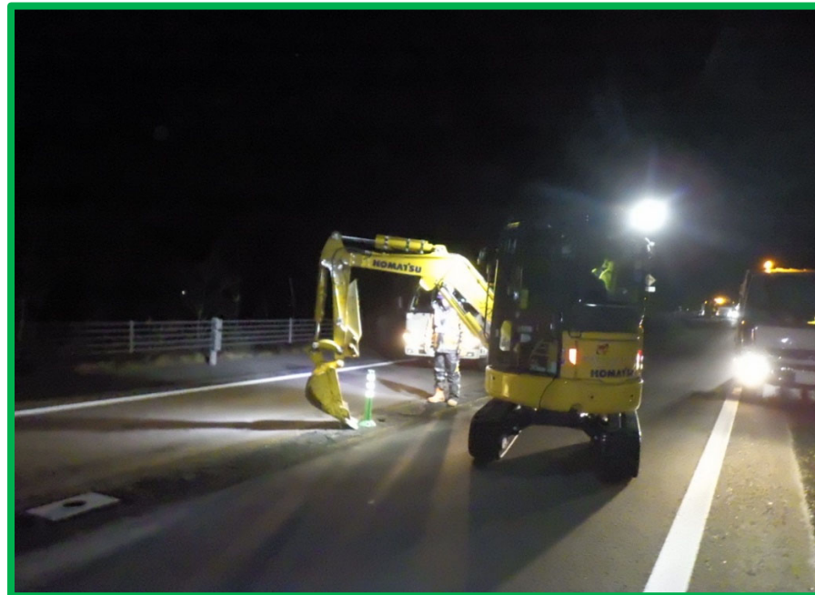
既設ラバーポール撤去状況(機械)
