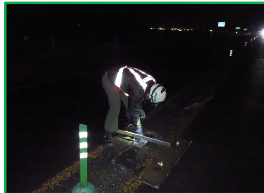
コア削孔スプレーマーキング状況
