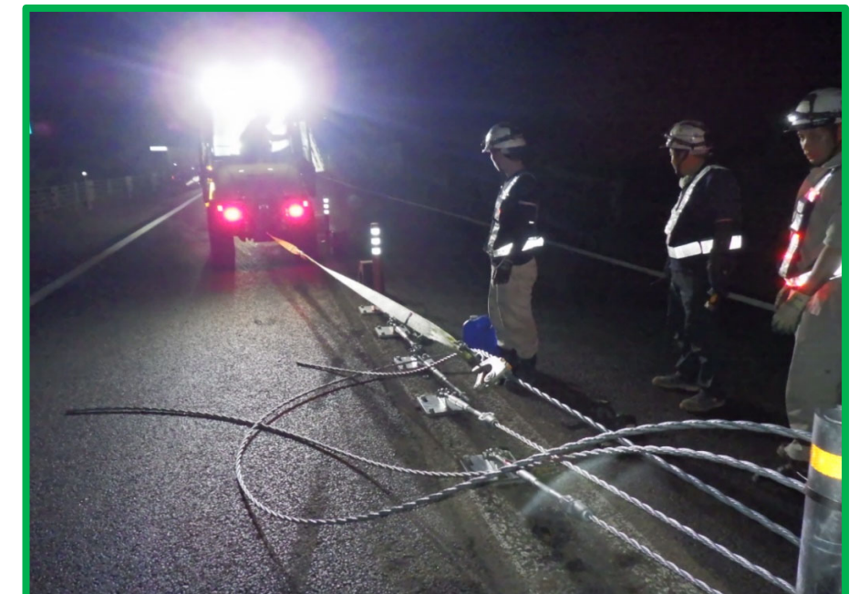
ワイヤーロープ 仮緊張状況(重機使用)
