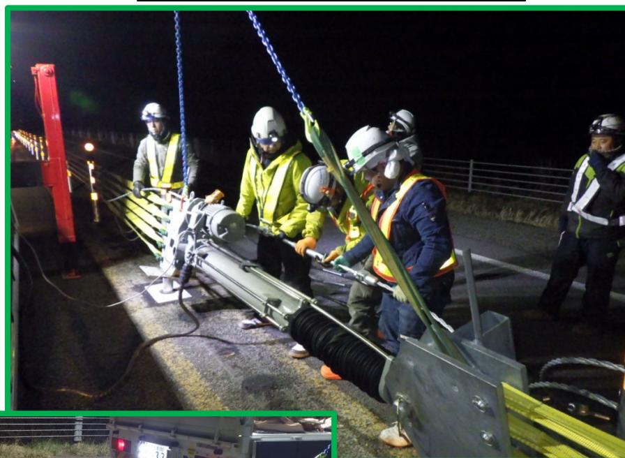
パワーリジダー使用による一括施工状況
