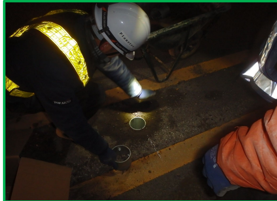
スリーブ 鋼管隙間詰め状況
