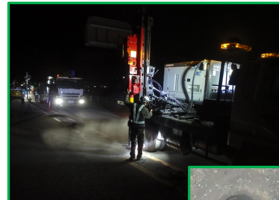
岩削状況(車両型岩削機)
