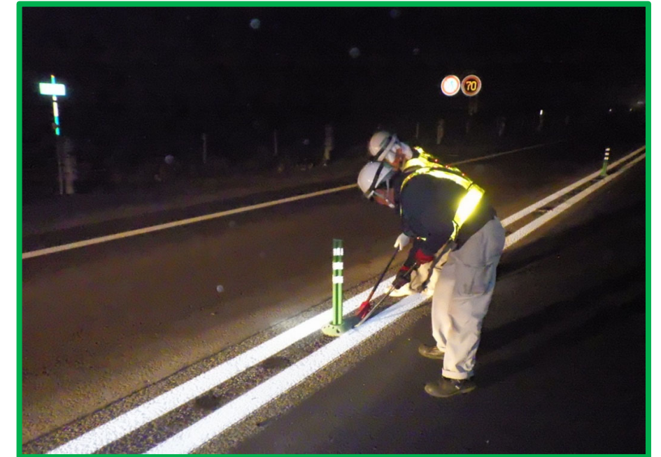
既設ラバーポール撤去状況(人力)
