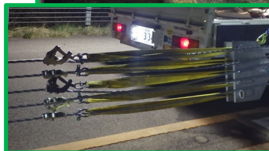
ターナックル締付け状況
