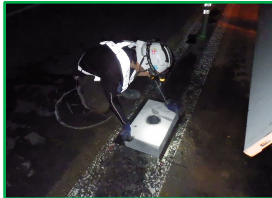
基礎ブロック設置状況
