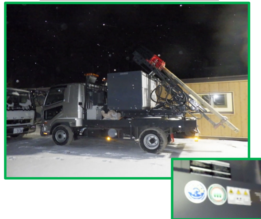
車両型岩削機【A・O-3500】 コンプレッサー搭載【PDS265SC】 (中間・端末支柱岩削用)
