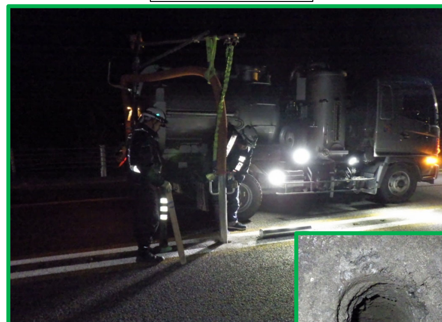
削孔内土砂回収状況
