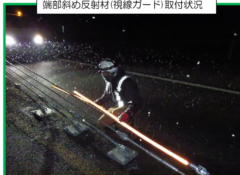
端部斜め反射材(視線ガード)取付状況
