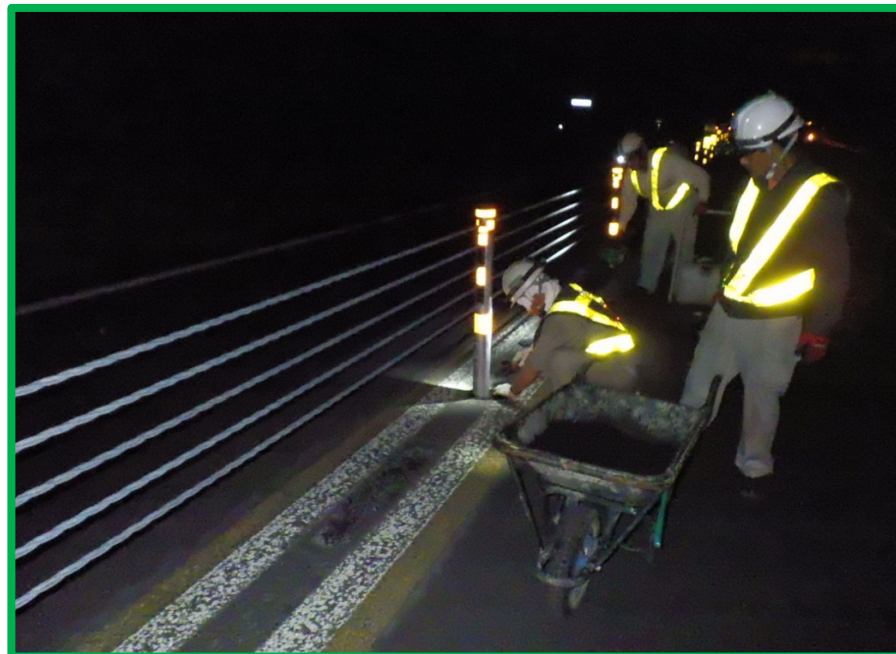
常温合材充填状況
