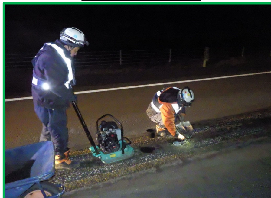
常温合材充填・転圧状況
