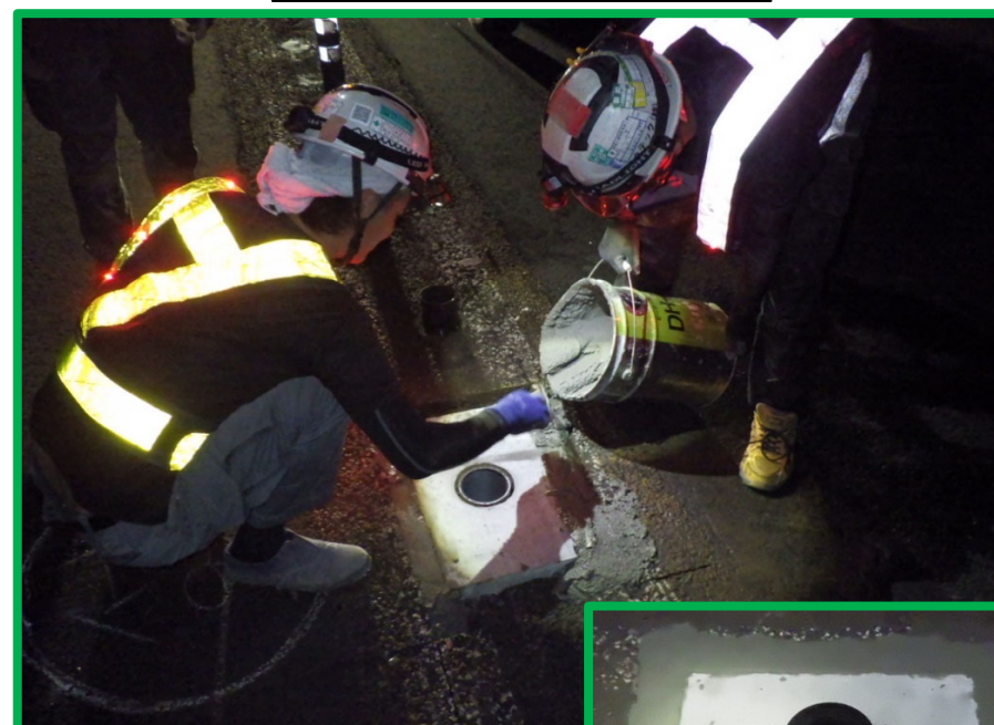
間詰復旧状況(グラウト使用)
