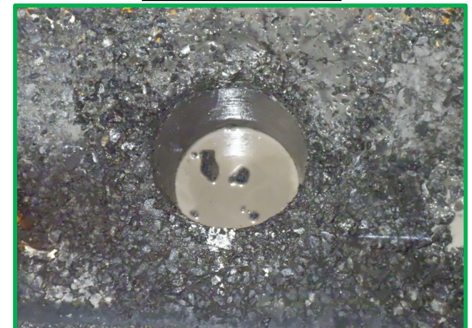
Asコア削孔完了(電動式)
