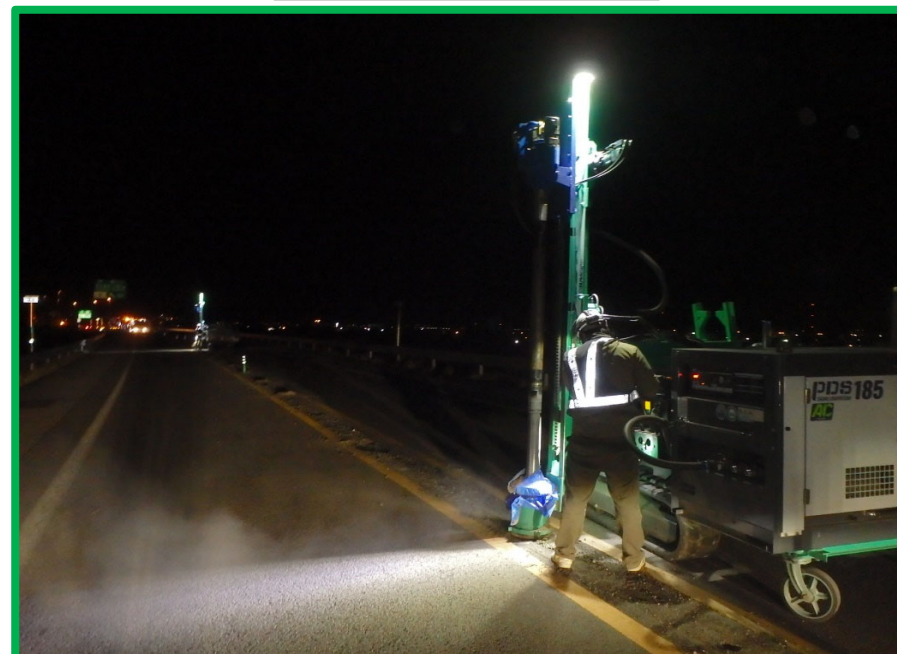
岩削状況(クロー式岩削機)
