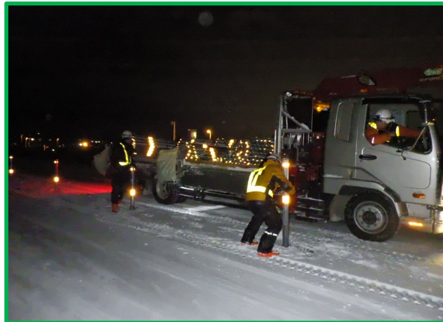
中間支柱建込み状況
