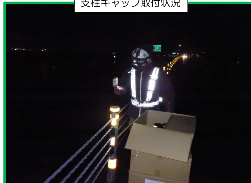
端部斜め反射材(視線ガード)取付状況
