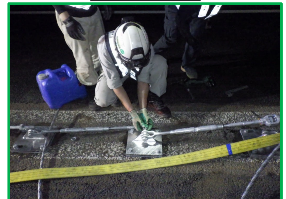
ジョーボルト固定状況
