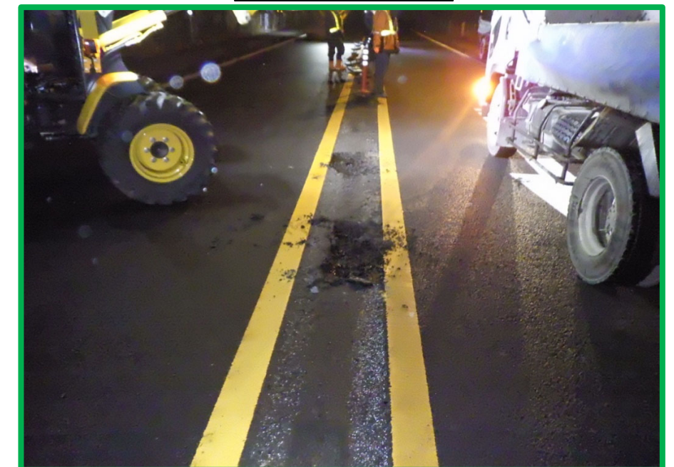
PCC縁石撤去完了
