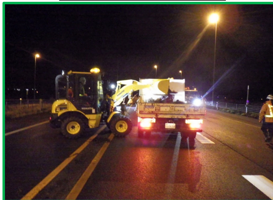
PCC縁石積込状況(4tダンプトラックへ)
