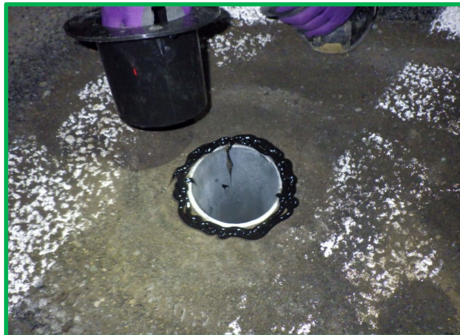
スリーブカバー設置状況
