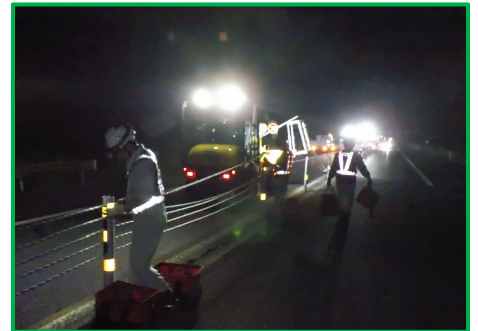
間隔材設置状況
